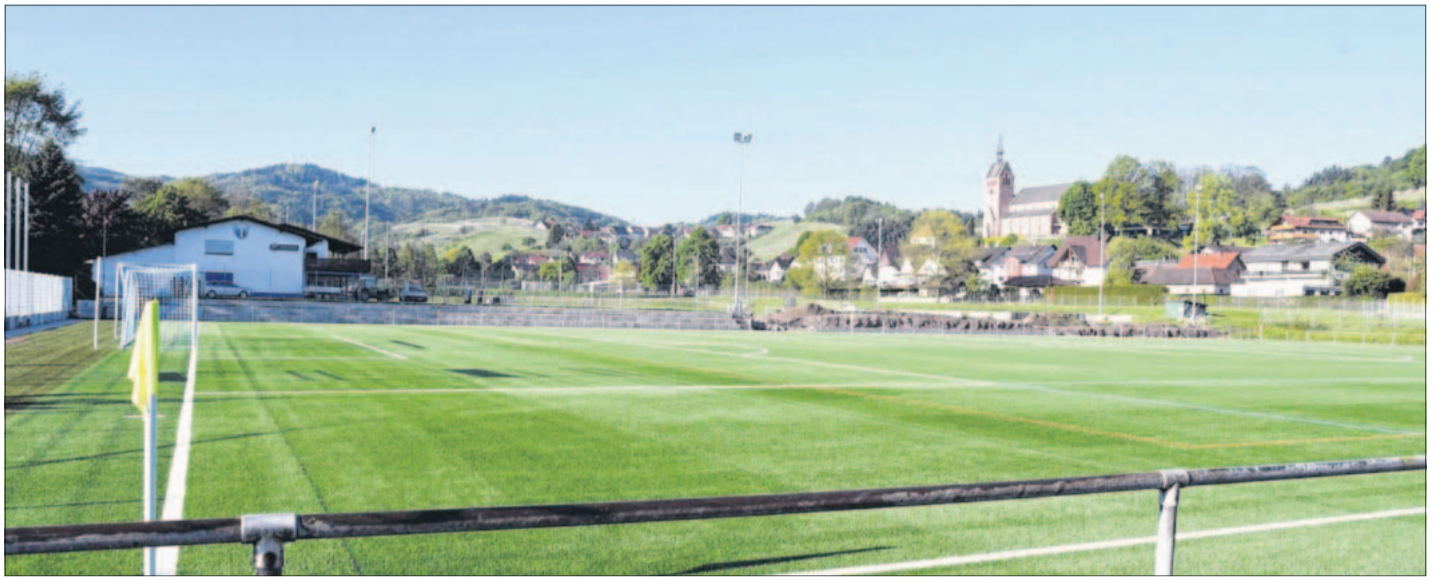
Auch bei der Anlegung des Kunstrasenplatzes war der Kappelrodecker Bauhof im Einsatz.
