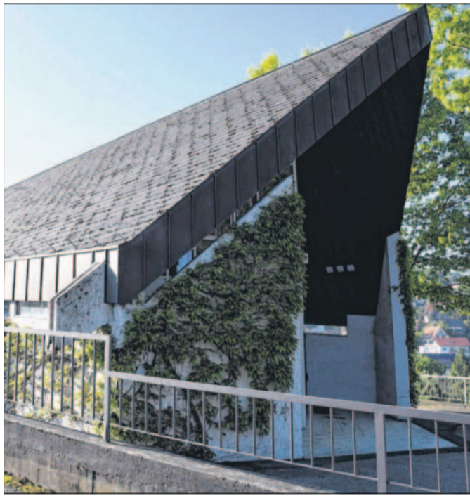
Die Einsegnungshalle auf dem Kappelrodecker Friedhof erhält ein neues Dach. Diese Maßnahme inspizierte der Technische Ausschuss am Montagabend. Foto: Berthold Gallinat
